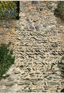
1. Opus spicatum an einer Mauer der Kernburg.
