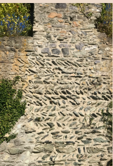
1. Opus spicatum an einer Mauer der Kernburg.
